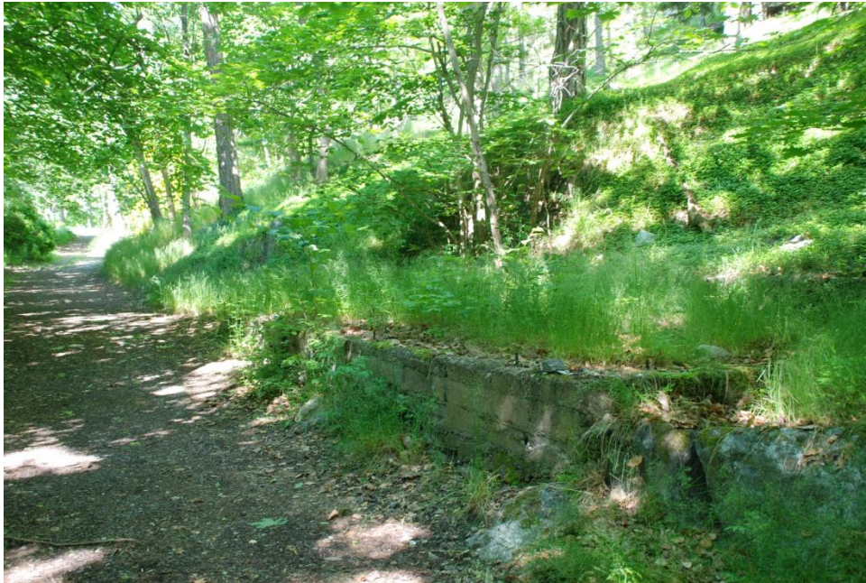
Fig. 20. Del av Saltstigen sett mot väster. Observera cement-fundamentet. Foto: Tomas Englund.
