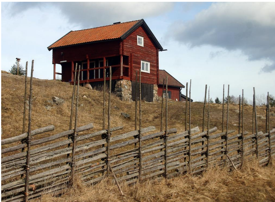
Fig. 19. Staket i form av Hankgärdsgård”.
